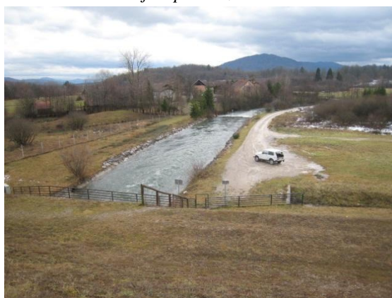
Slika 4: Iztok iz talnega izpusta
